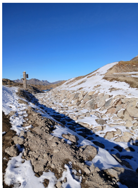
Travaux de la brèche et du chenal terminés.
