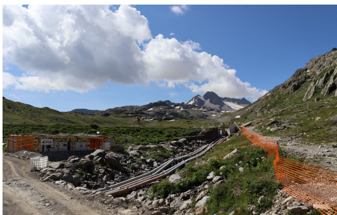
Travaux au Lac Blanc.
