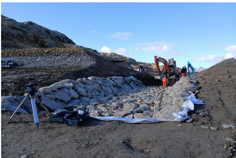
Enrochement du chenal.
