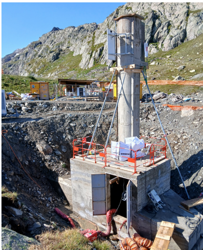
Ouvrage dans lequel se situe la vanne de vidange du lac Blanc.
