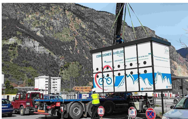
Installation de consignes à vélos sécurisées.
