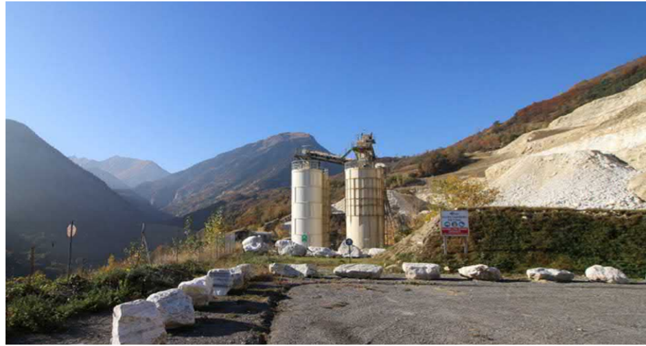
VUE 1 - Parking du site de la carrière actuelle donnant sur les silos de stockage
