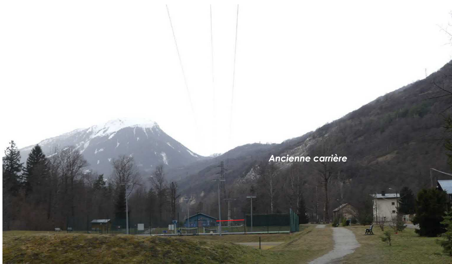
VUE 15 - Depuis la zone de loisir le long de l'Arvan, après le cimetière. On aperçoit l'ancienne carrière et la future extension - vue hivernale
