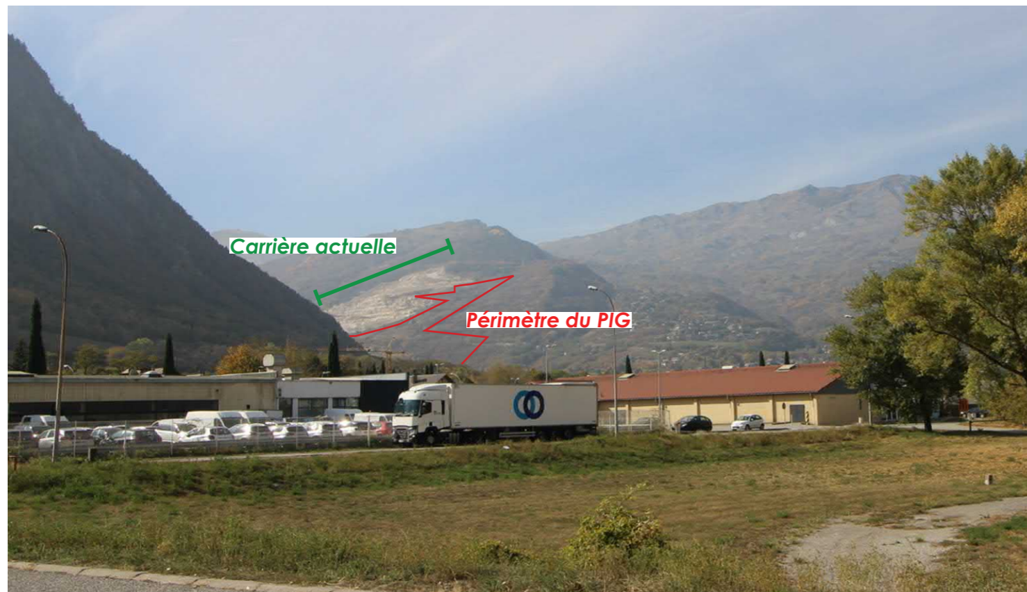
VUE 3 - La photo a été prise depuis la zone d'activité de Saint Jean-de-Maurienne
